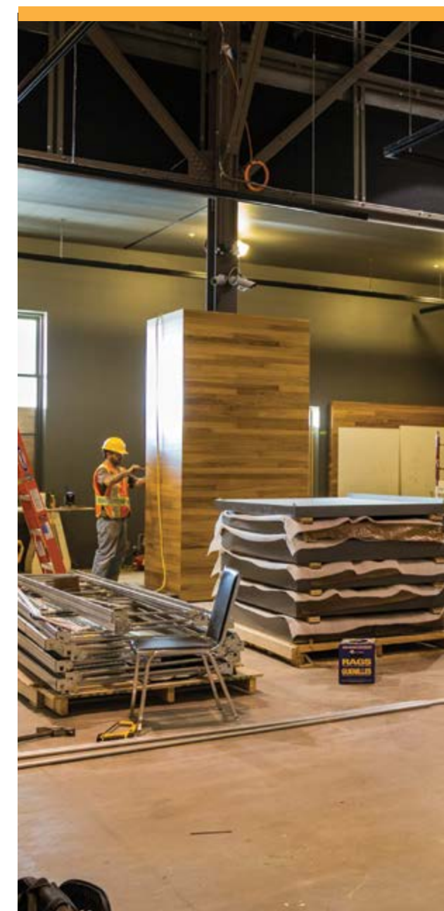
La construction du nouvel espace d'exposition.
